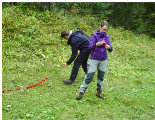
Installation des flotteurs par les bénévoles - A Mottet (GTJ)
